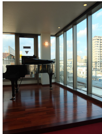
カリン材フローリング張りステージ
