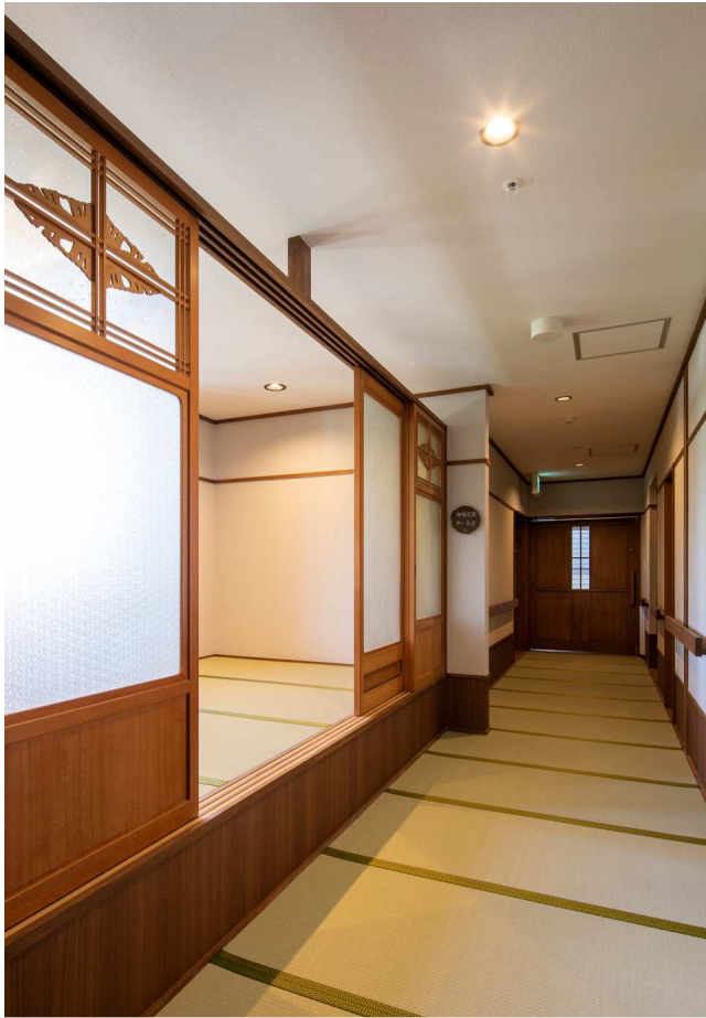
2階廊下/古民家から移設・再利用した木製建具
