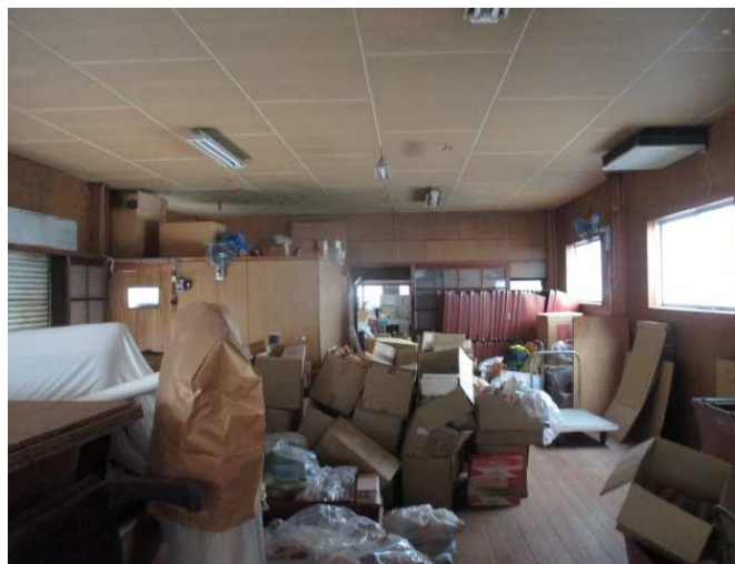
工事前の玄関ホール付近。中央左のボックスが事務室に
