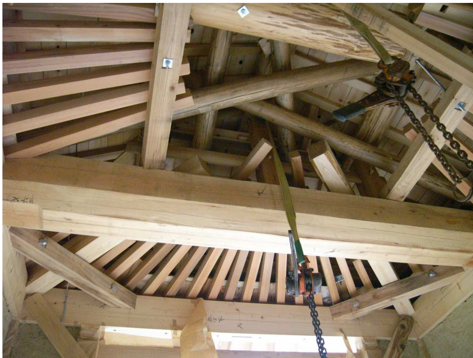
屋根裏を見る
