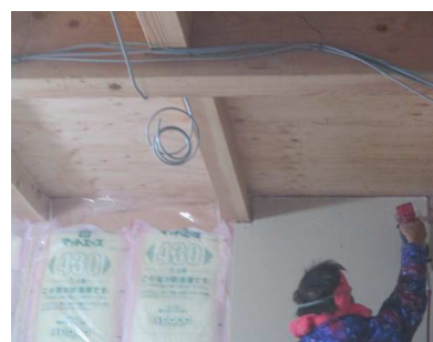
外壁断熱+気密シート張
