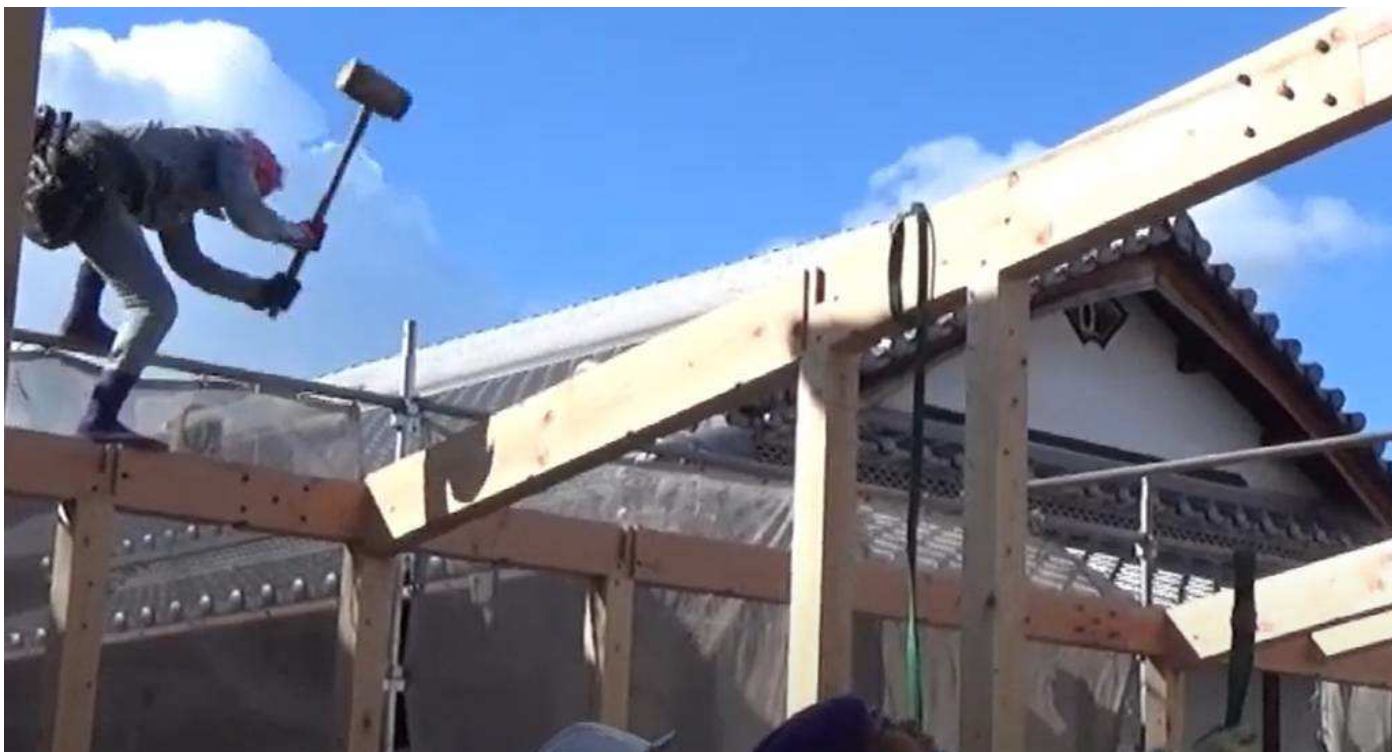
掛矢を使って“昔ながら”建て方作業風景
