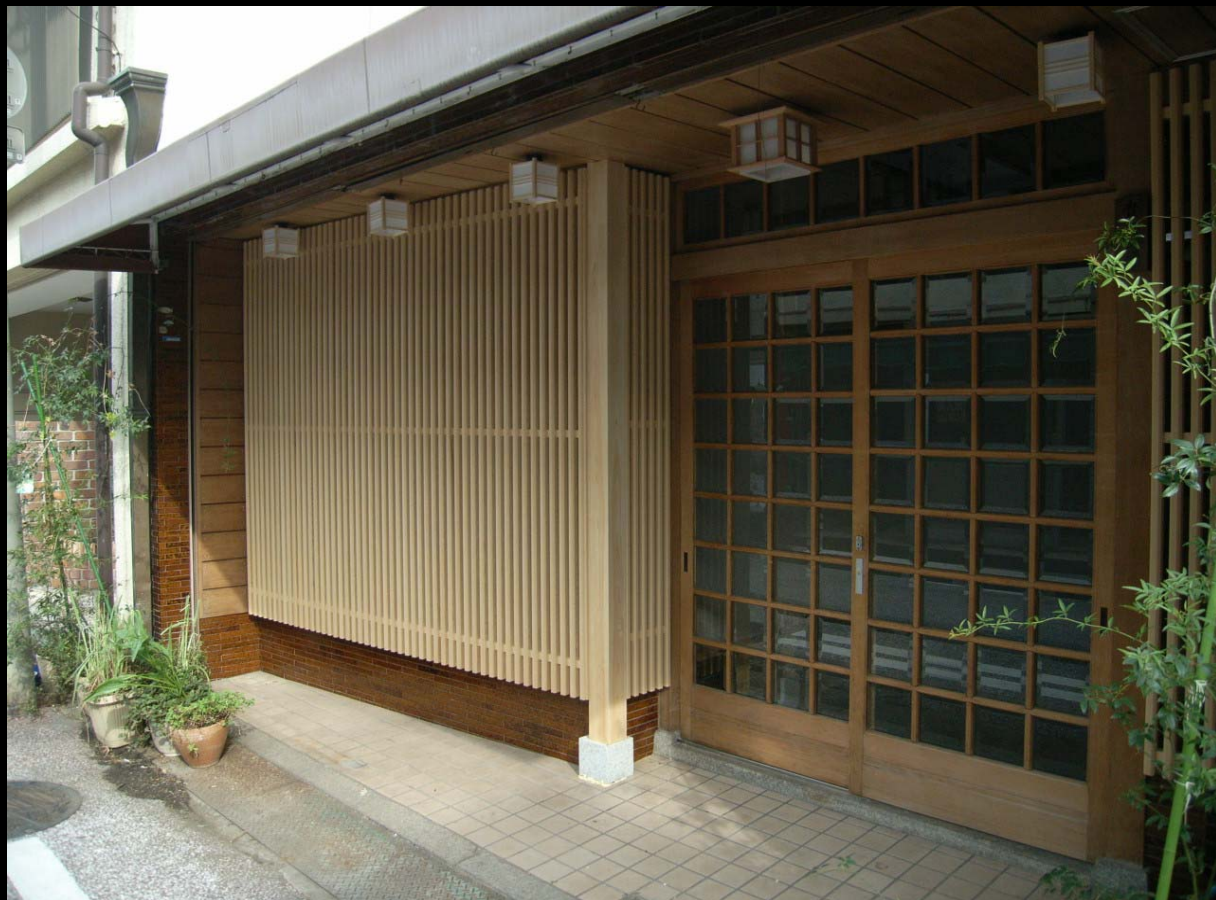
改装後外観(右は既設玄関ガラス戸)
