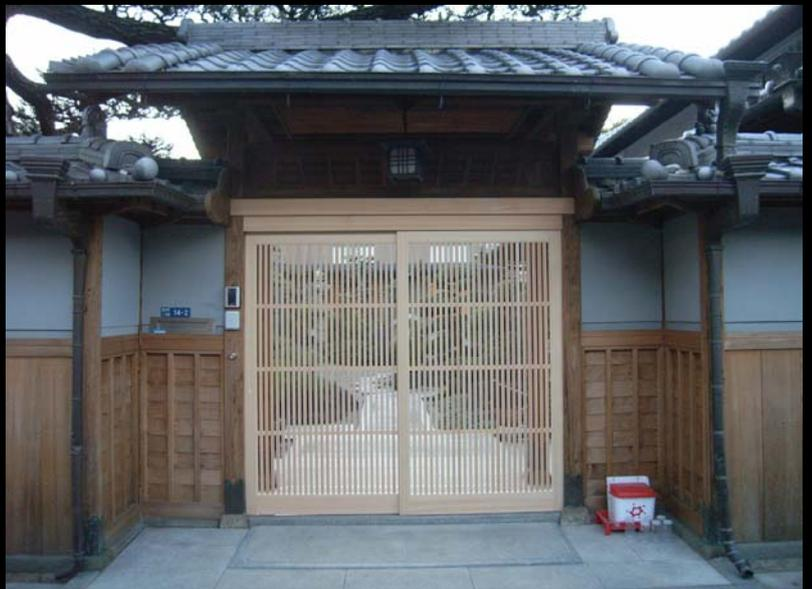
取替えた格子戸／空きを調整し中庭は正面方向だけ少し見える。松の根で大きくねじれた門を左の塀の中にカ板を仕込んで補正。
