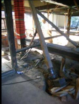
02.17 ジャッキで倒れ補正
