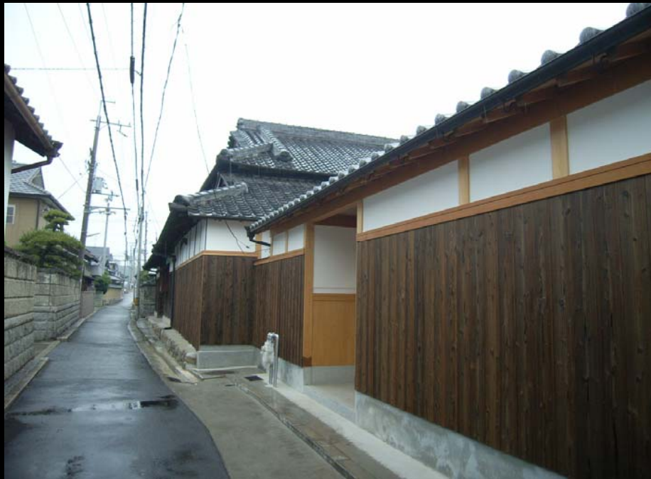
道路側全景(改修後)
