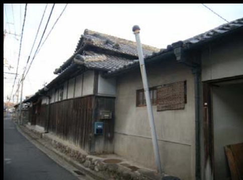
道路側全景(改修前)
