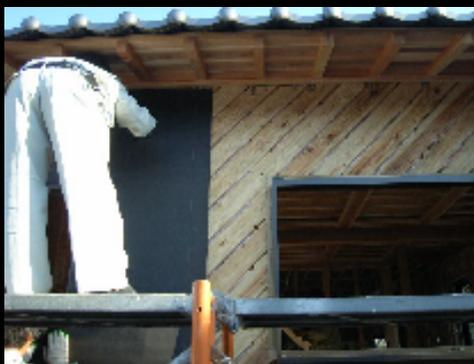
ラス下地板 斜め張り(隙を外壁通気工法に応用)
