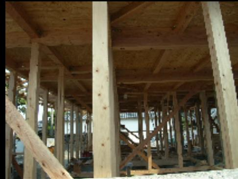
小屋組梁天端水平全面に構造用合板張(断熱材充填)
