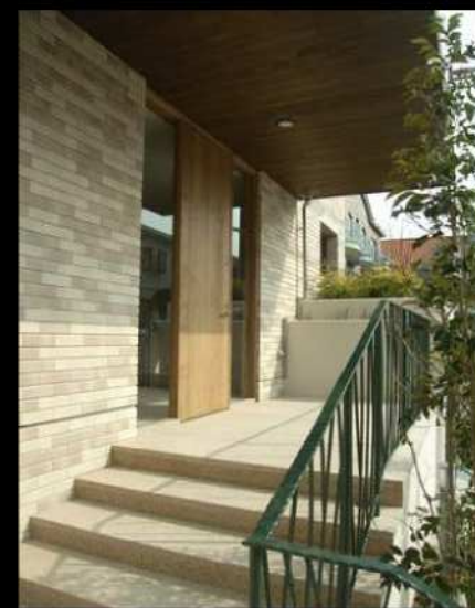
レッドオークの玄関扉・樺の軒天井
