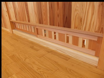
2階会議室の風抜き無双窓
