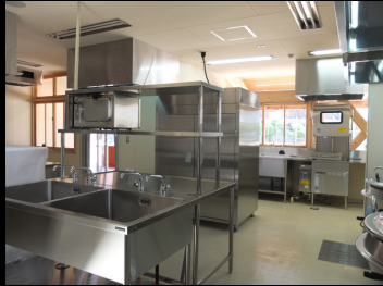
保育室・廊下に面した厨房
