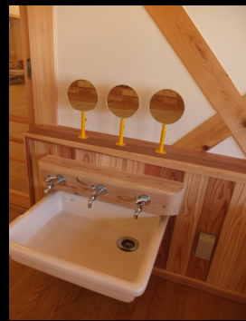
ペアガラス+カラーガラスの木製実験流し利用のローコスト手洗
