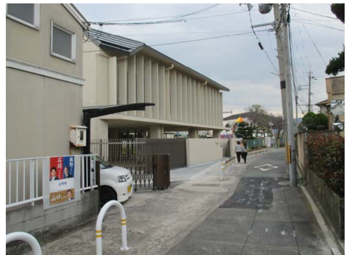
外観ルーバーは日射熱への省エネ装置
