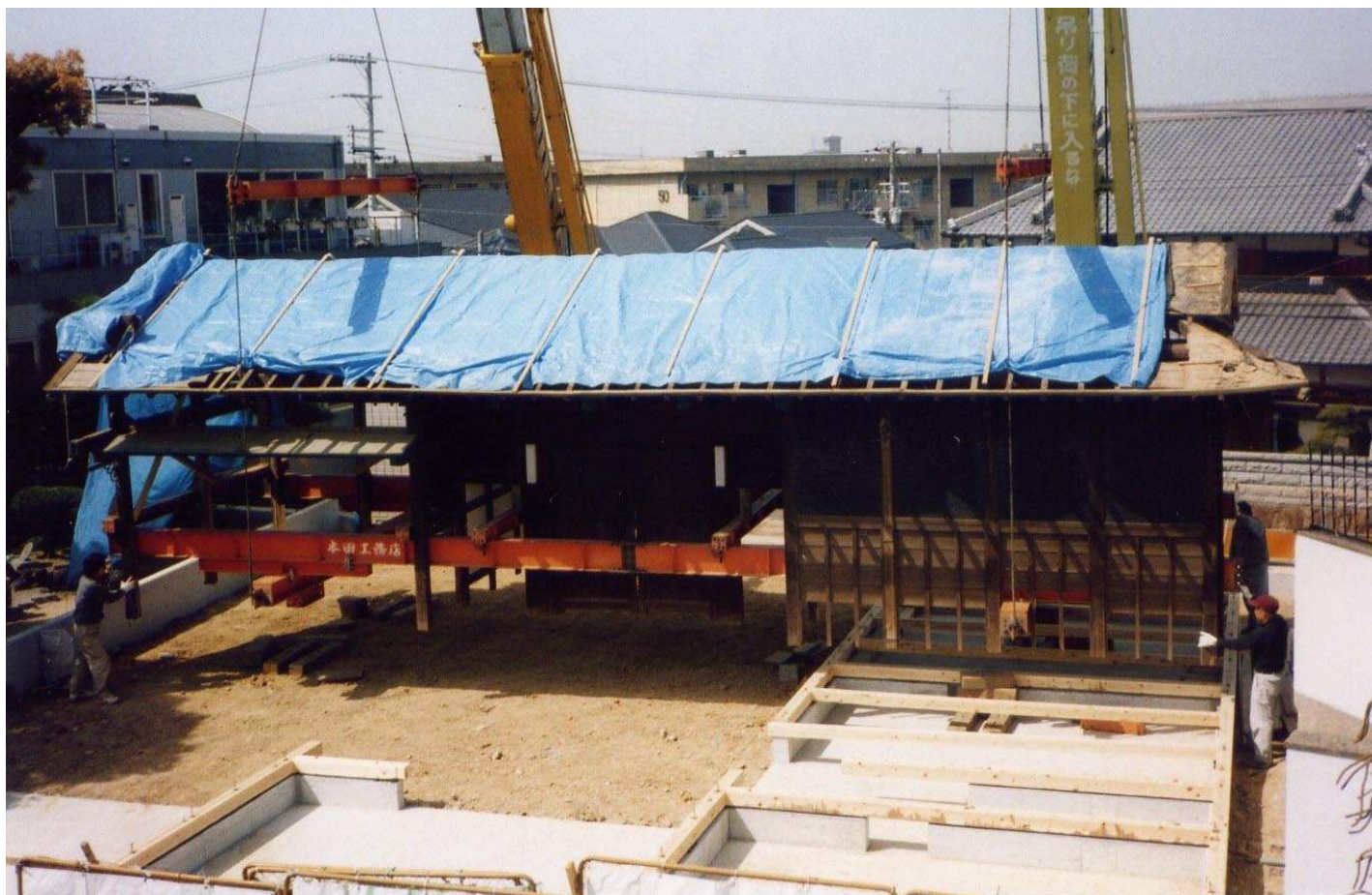
工事風景：クレーンで移動中の門屋。腰板、押し縁もつけたまま
