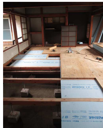
束・敷石増設+下地組補強と断熱材、
