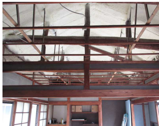
野地板下全面に吹付け断熱
