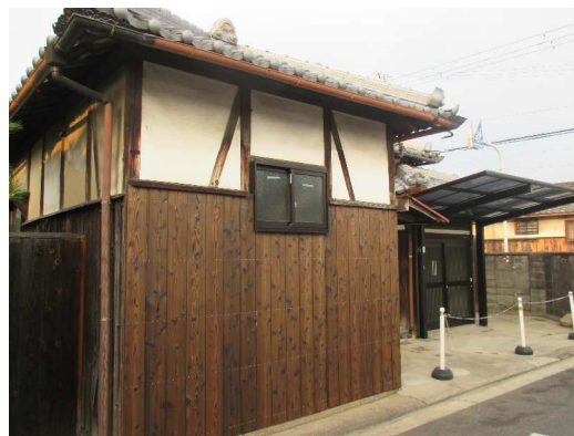
杉板を捲って不良部材取替と薬剤散布
