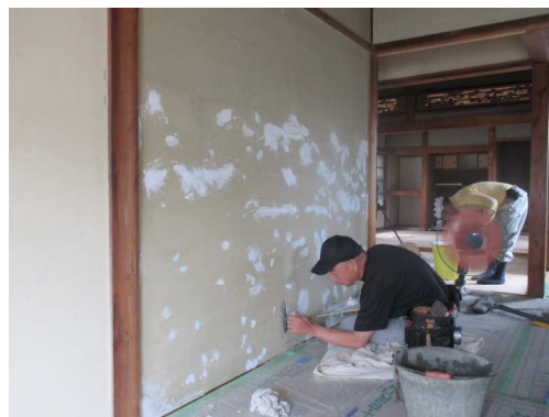
上塗りケレン、傷、凹凸処理
