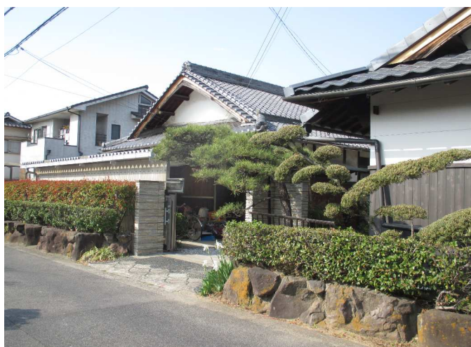
手前は改修後の離れ。奥はこれから改修予定の母屋
