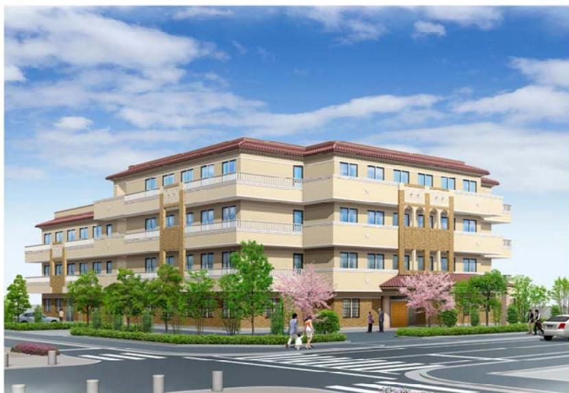
装飾壁は建設費高騰の折、職人不足、コスト制限から伝統的な工法の採用は難しく、現代的な材料と工法により少しでも近いものにとの思いと、市松タイル張りについては特注寸法によるタイル割りの現場施工であえてラフな仕上がりをイメージしている。一時はタイル打ち込みパネルも検討したが、最後は“ラフ”を選択した。
