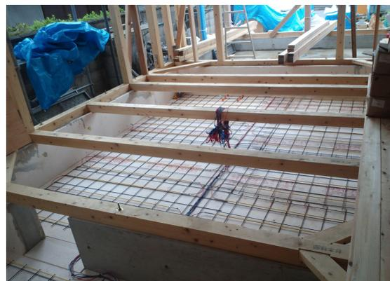
■ 床下蓄熱暖房(エナーテック社)を採用。断熱材の上の土間コンで1階床下が全て蓄熱槽。
