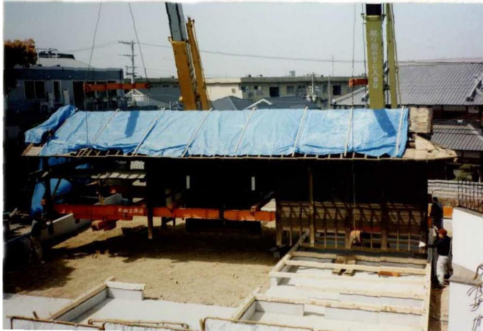
「和泉・長屋門再生の家」 曳き工事で先行工事の基礎の上に吊り上げて移動中
